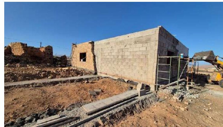
Fig 38. Estado actual del inmueble
