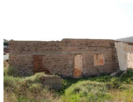
Fig 144. Construcción de “pared de cajón” en Guisguez
