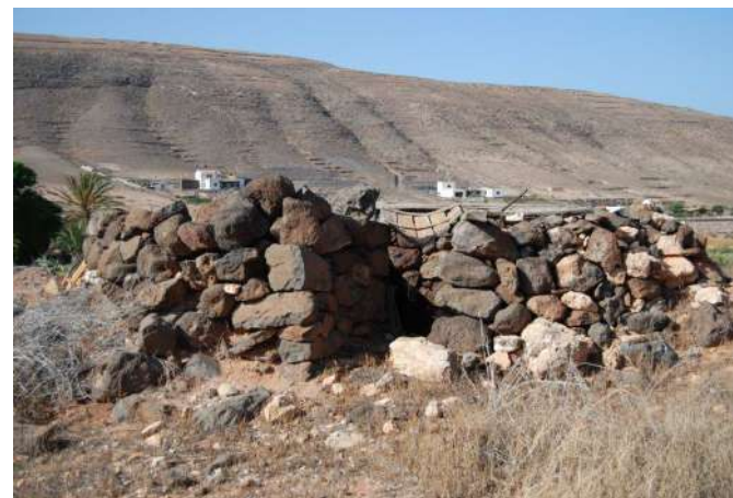
Fig 57. Estado del inmueble en los Estudios Previos de 2019
