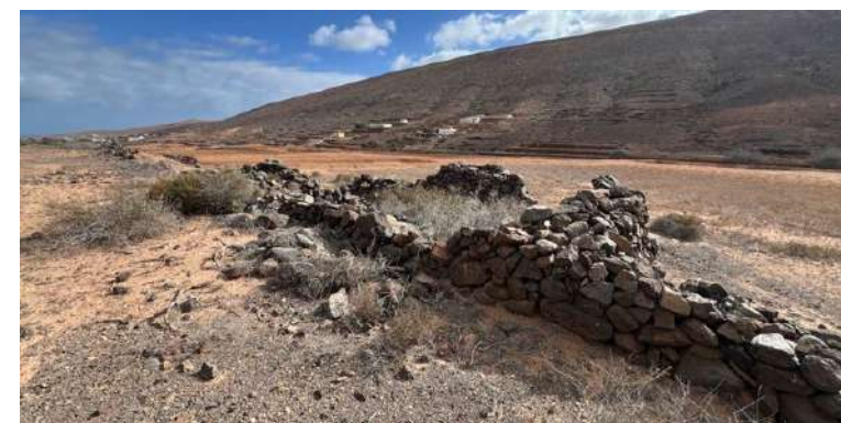
Fig 66. Estado actual del inmueble
