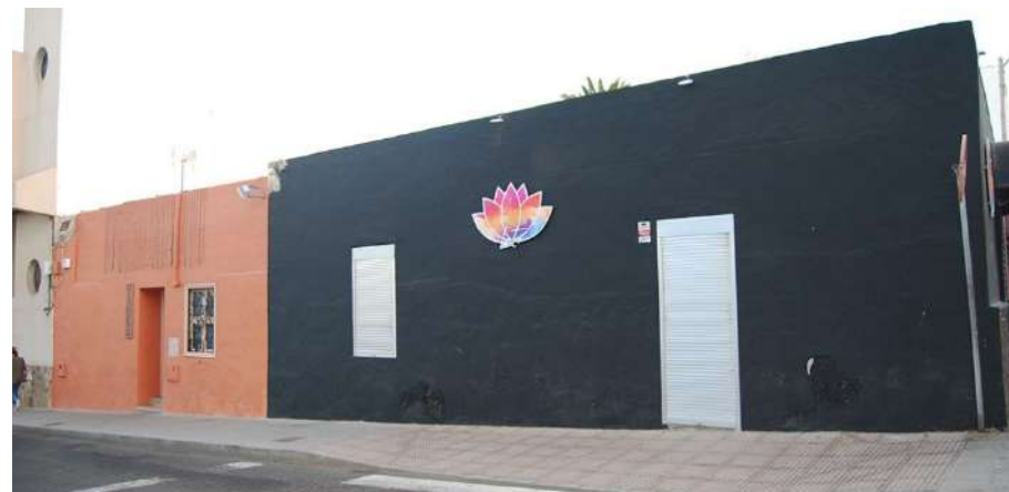
Fig 73. Estado del inmueble en los Estudios Previos de 2019
