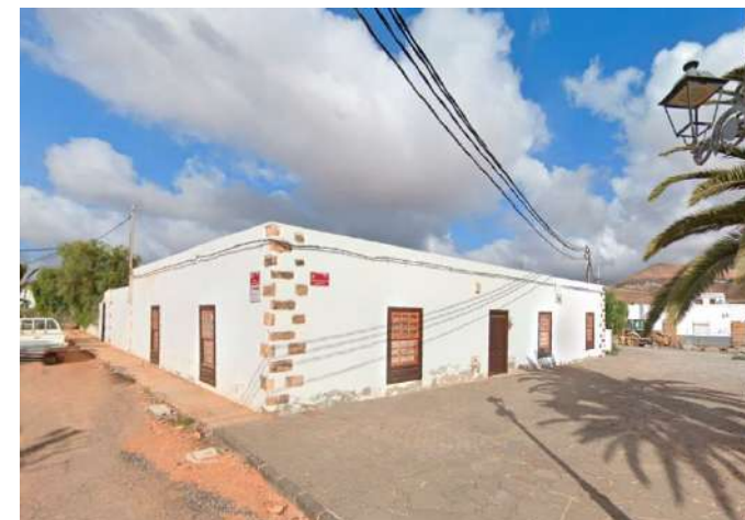
Fig 164. AR-131. Vivienda tradicional del TIPO 11.1 en Casillas del Ángel
