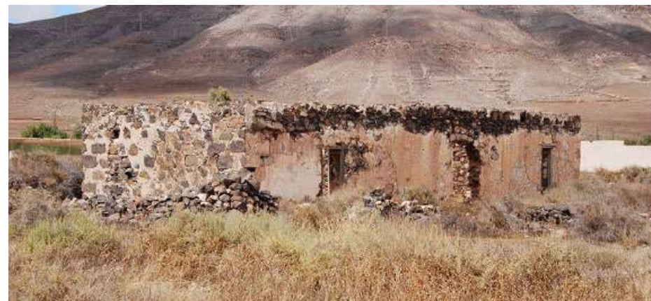
Fig 147. Vivienda tradicional con fachada encalada en su totalidad y pared lateral con encalado solo en las juntas de las piedras, predominando el color terroso.
