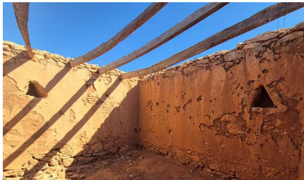
Fig 17. Ventanucos triangulares para favorecer la ventilación del inmueble
