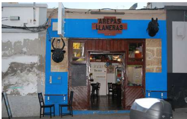
Fig 71. Estado del inmueble en los Estudios Previos de 2019
