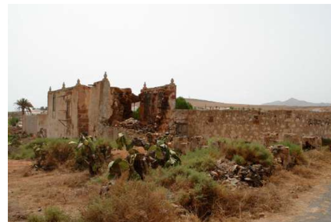
Fig 150. AR-216: Vivienda tradicional del TIPO 1.3 en Casillas del Ángel
