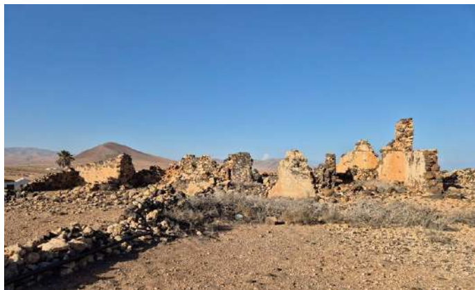
Fig 36. Estado actual del inmueble
