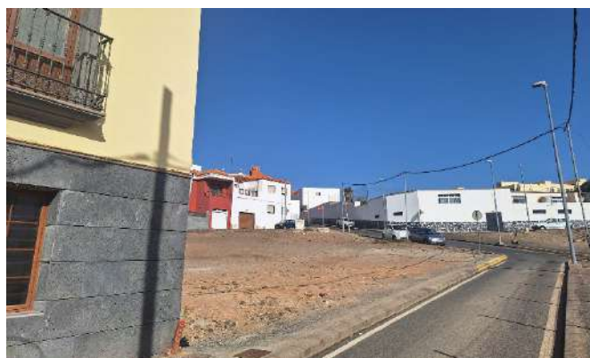
Fig 76. Estado actual del inmueble
