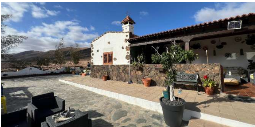
Fig 80. Estado actual del inmueble
