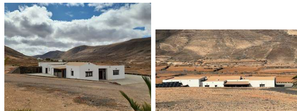
Fig 34. Estado actual del inmueble
