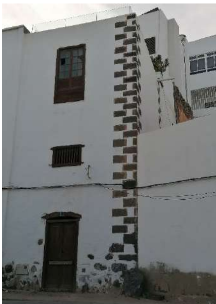
Fig 127. AR-325. Inmueble en calle Encarnación Hormiga 12
