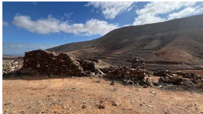
Fig 64. Estado actual del inmueble
