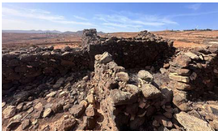
Fig 44. Estado actual del inmueble
