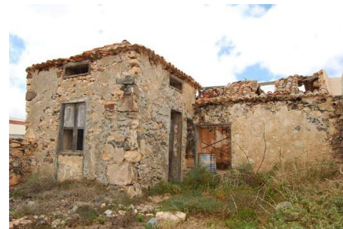
Fig 156. AR-167. Vivienda tradicional del TIPO 4.2 en Casillas del Ángel
