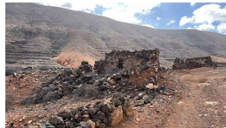
Fig 62. Estado actual del inmueble
