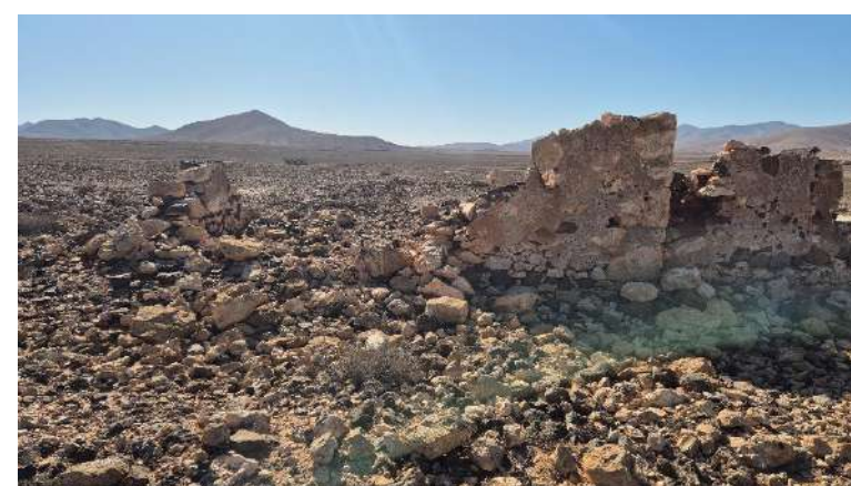
Fig 54. Estado actual del inmueble
