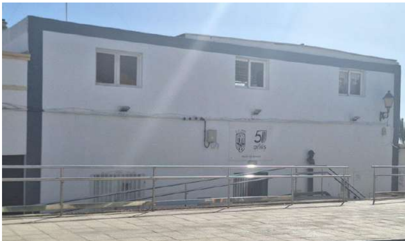
Fig 68. Estado actual del inmueble
