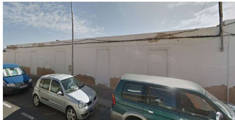
Fig 129. AR-379. Inmueble en calle Juan Domínguez Peña 18. Antigua panadería
