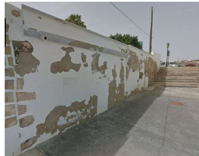
Fig 125. AR-322. Inmueble en calle Encarnación Hormiga 2
