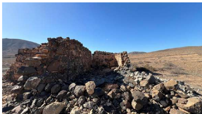
Fig 52. Estado actual del inmueble
