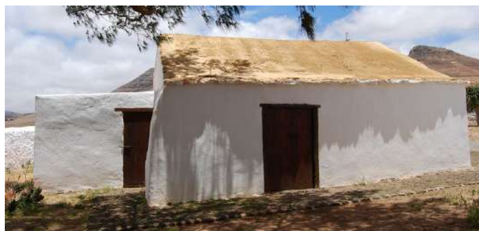
Fig 232. Casa de Fray Andresito de La Ampuyenta
