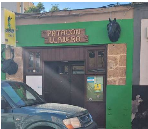
Fig 72. Estado actual del inmueble
