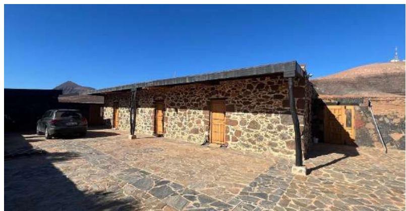
Fig 40. Estado actual del inmueble
