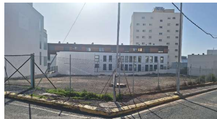
Fig 78. Estado actual del inmueble
