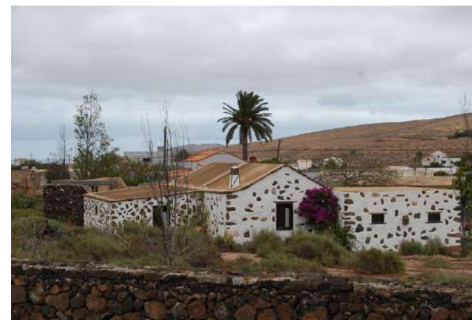
Fig 159. AR-240. Vivienda tradicional del TIPO 6, en Casillas del Ángel
