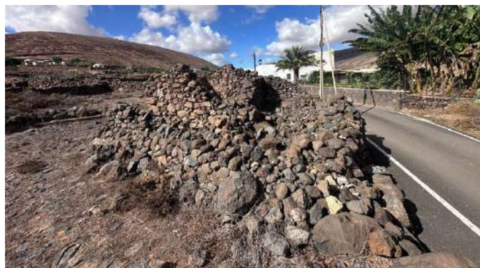
Fig 56. Estado actual del inmueble
