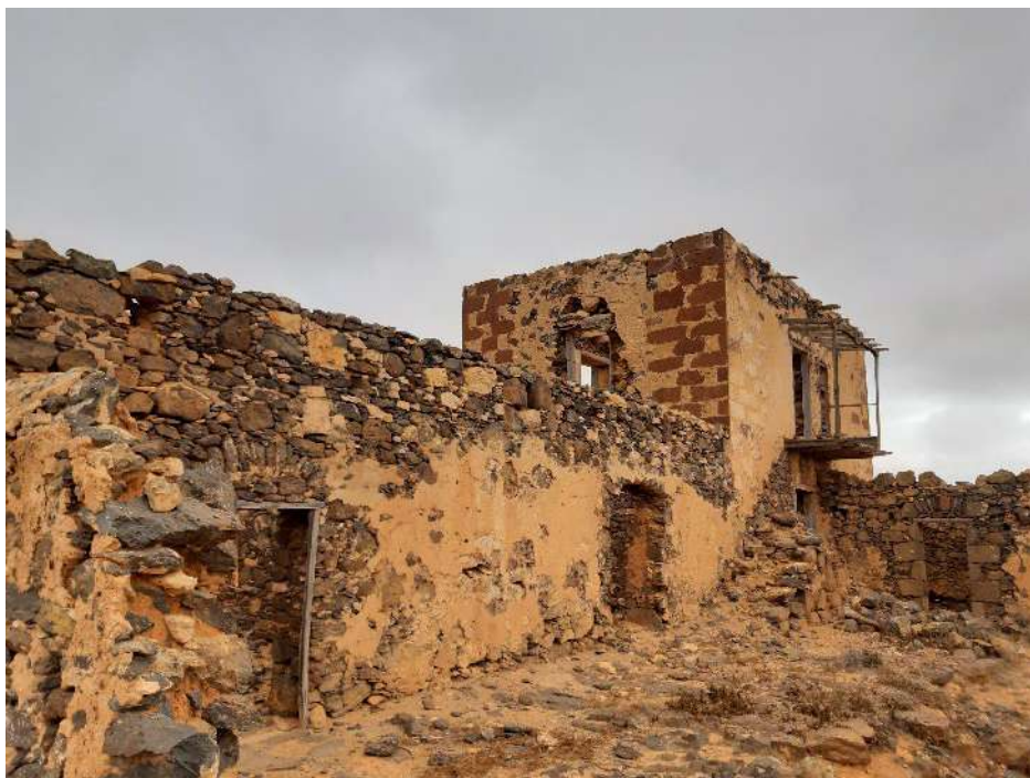
Fig 20. Viviendas en el contexto rural, de una planta y sobrado.
