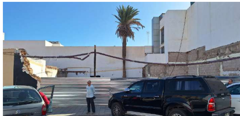
Fig 74. Estado actual del inmueble
