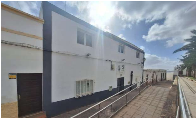
Fig 67. Estado del inmueble en los Estudios Previos de 2019
