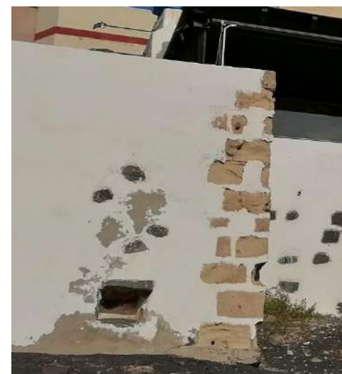
Fig 102. Fachada trasera- muro de contención y salida de agua
