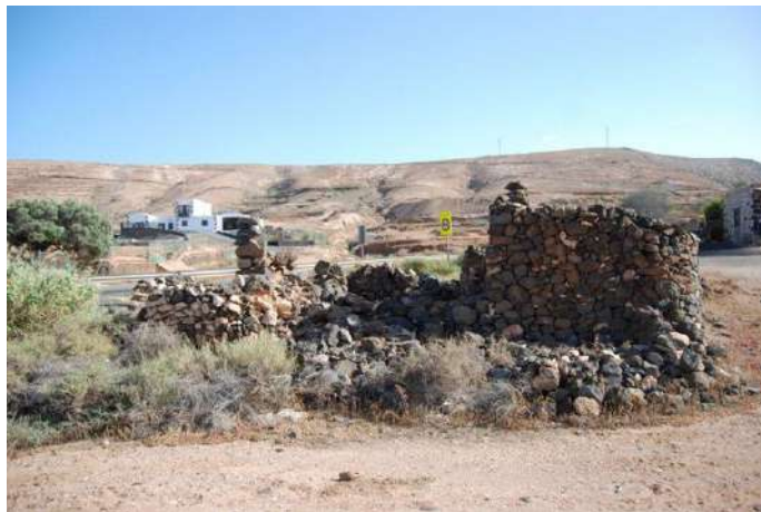
Fig 59. Estado del inmueble en los Estudios Previos de 2019
