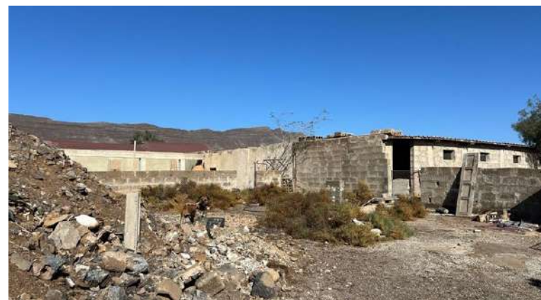
Fig 46. Estado actual del inmueble
