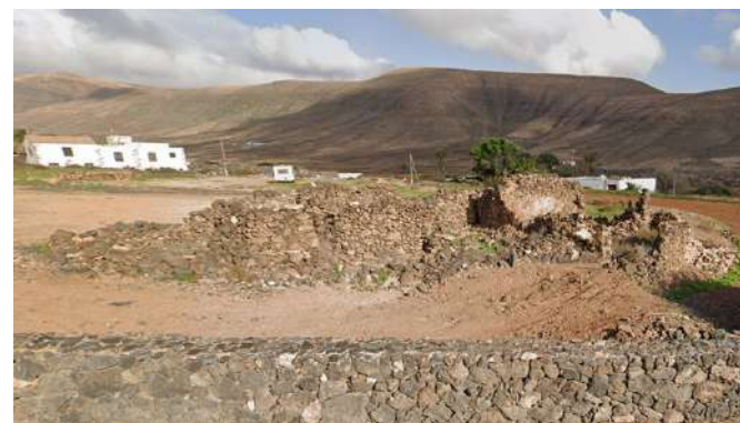
Fig 58. Estado actual del inmueble
