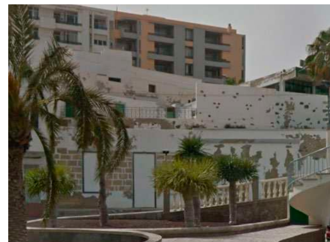
Fig 126. AR-324. Inmueble en calle Encarnación Hormiga 6
