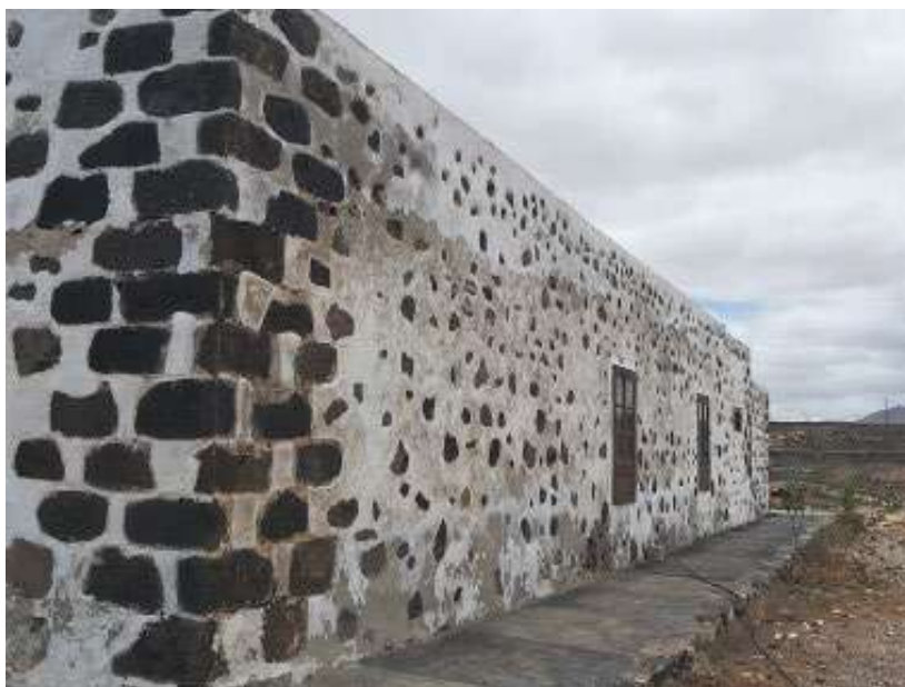
Fig 145. Llagueado en una vivienda tradicional de Fuerteventura
