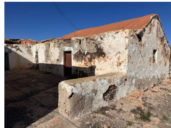
Fig 155. AR-238. Vivienda tradicional del TIPO 4.1 en Casillas del Ángel
