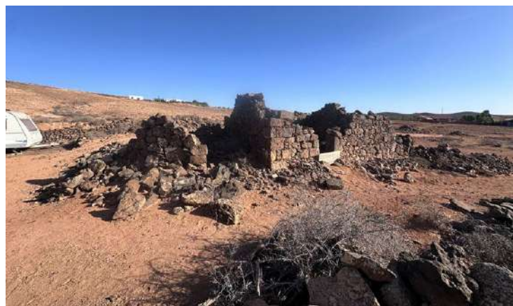
Fig 48. Estado actual del inmueble
