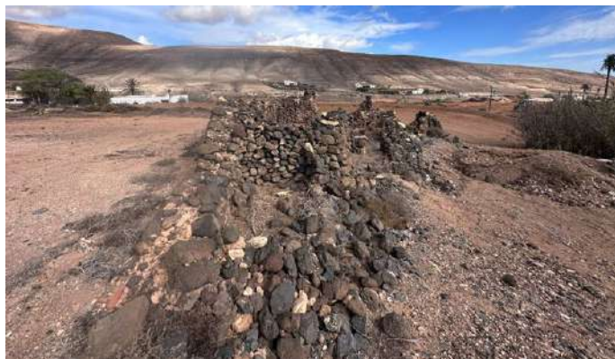
Fig 60. Estado actual del inmueble
