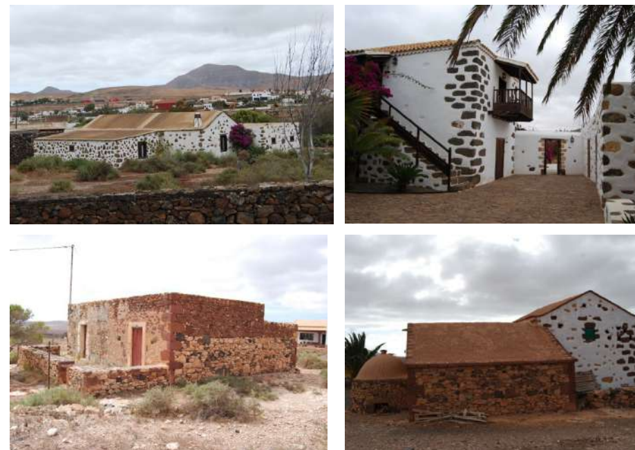
Fig 4. Casas tradicionales en buen estado
