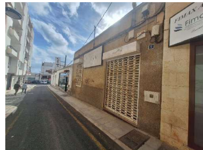
Fig 70. Estado actual del inmueble
