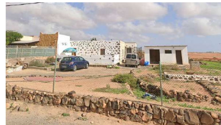
Fig 50. Estado actual del inmueble
