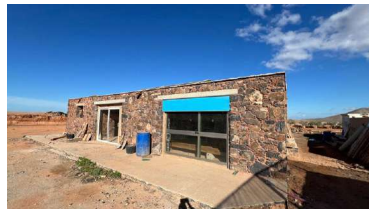
Fig 42. Estado actual del inmueble
